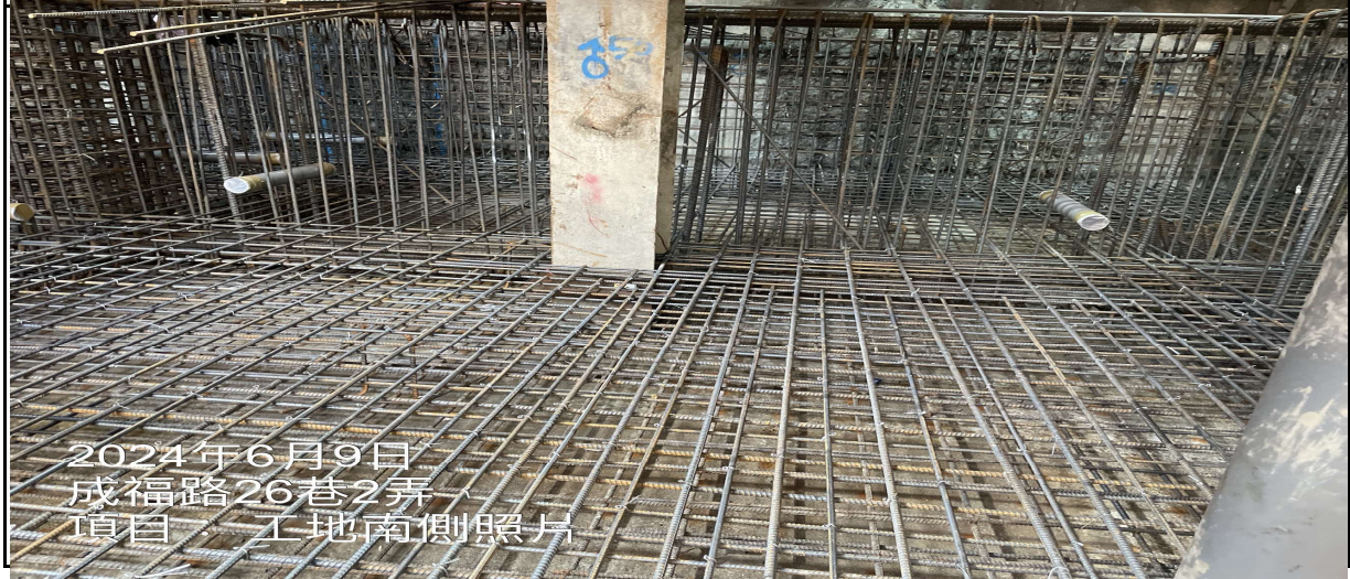
工程名稱：基礎版鋼筋綁紮
