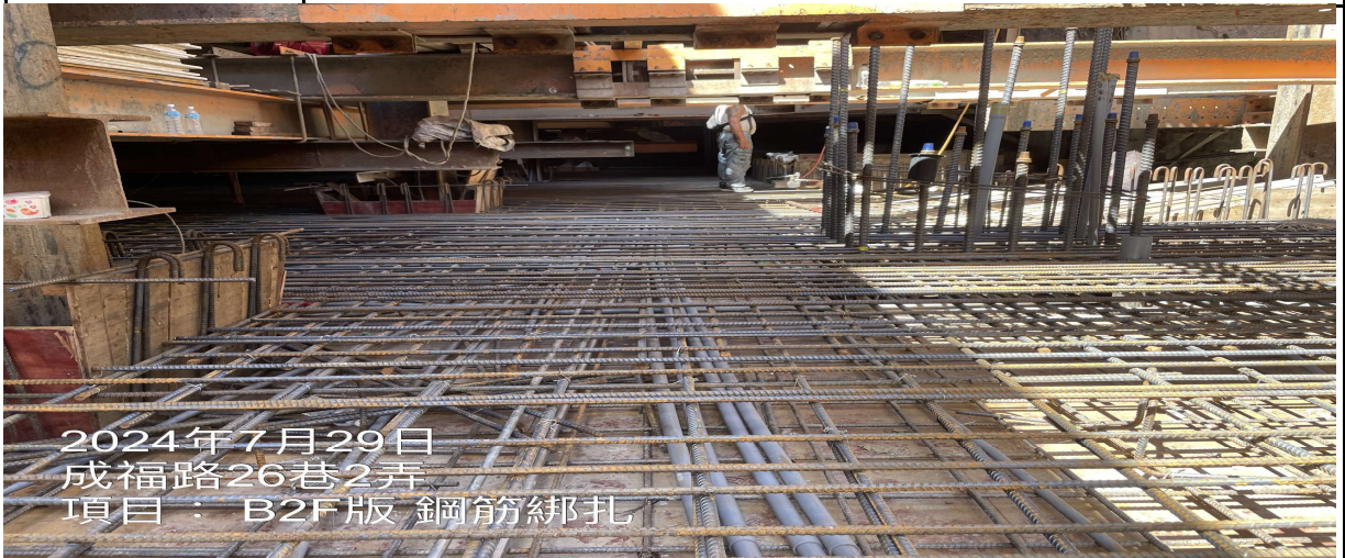
工程名稱：B2F版鋼筋綁紮
