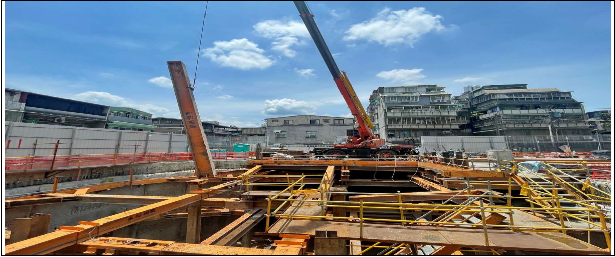
工程名稱：支撐第三撐拆除
