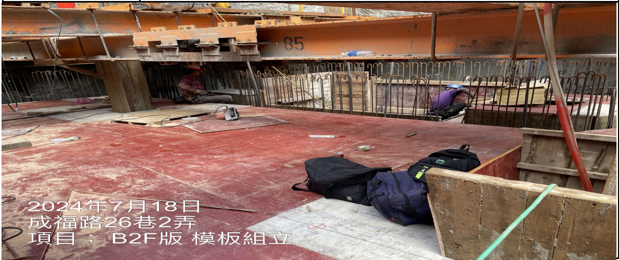
工程名稱：B2F版模板組立
