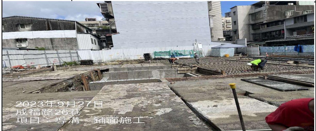
工程名稱：連續壁-導溝及鋪面
