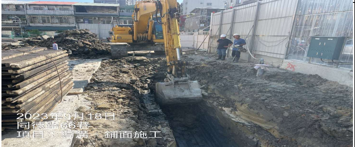
工程名稱：連續壁-導溝及鋪面
