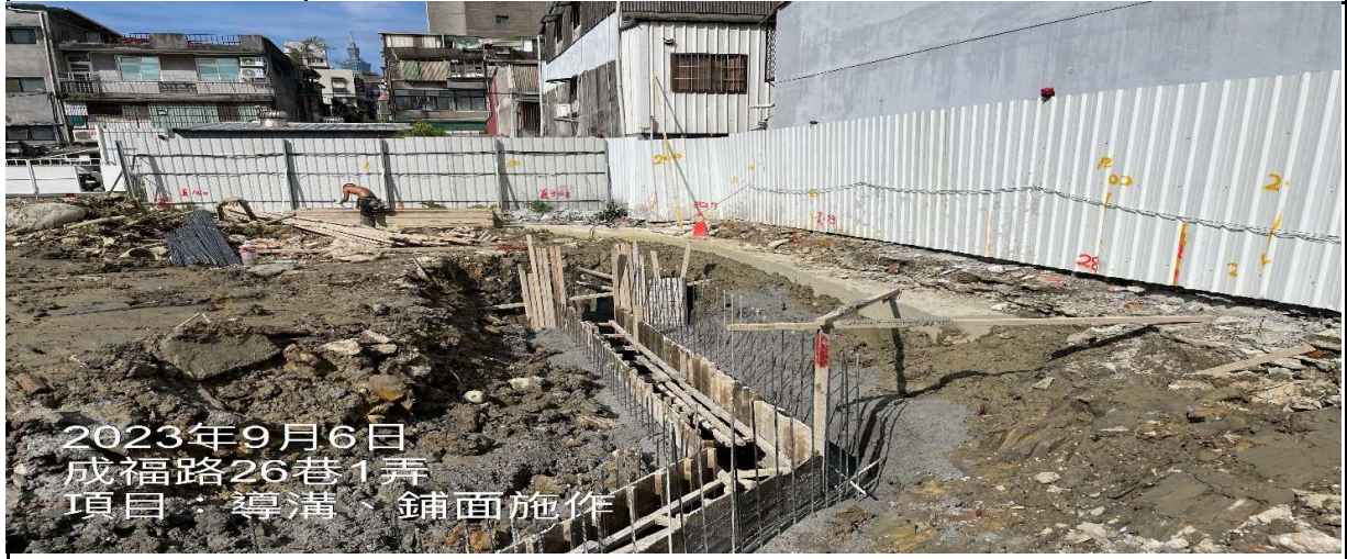
工程名稱：連續壁-導溝及鋪面
