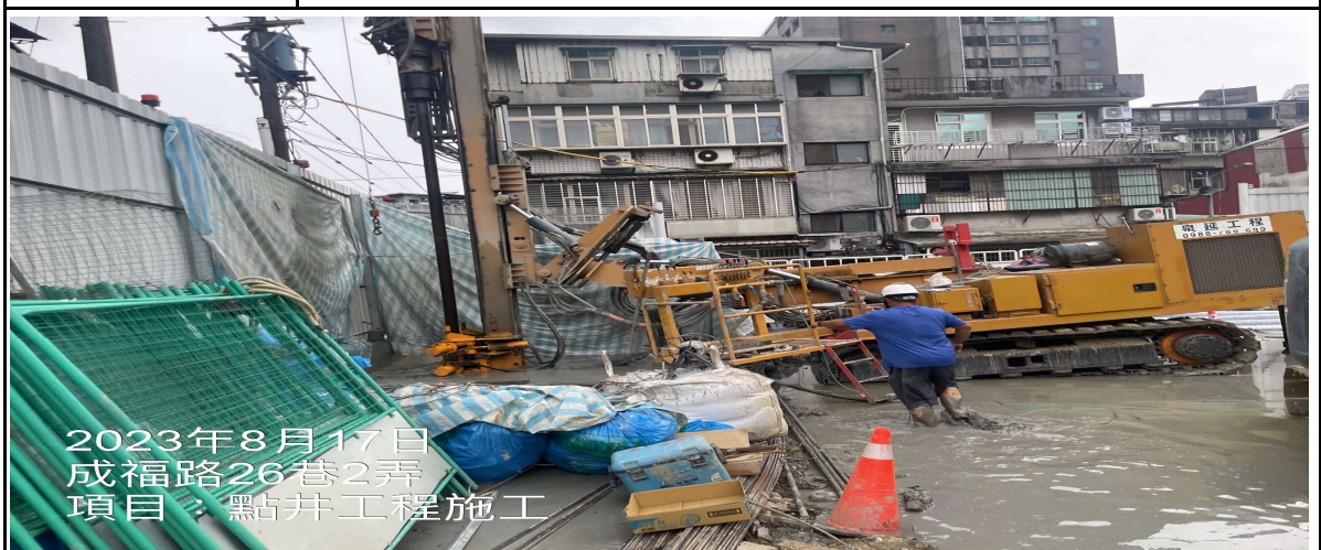
工程名稱: 點井施工
