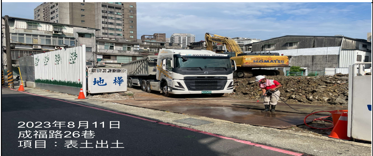
工程名稱: 工區內表土清理
