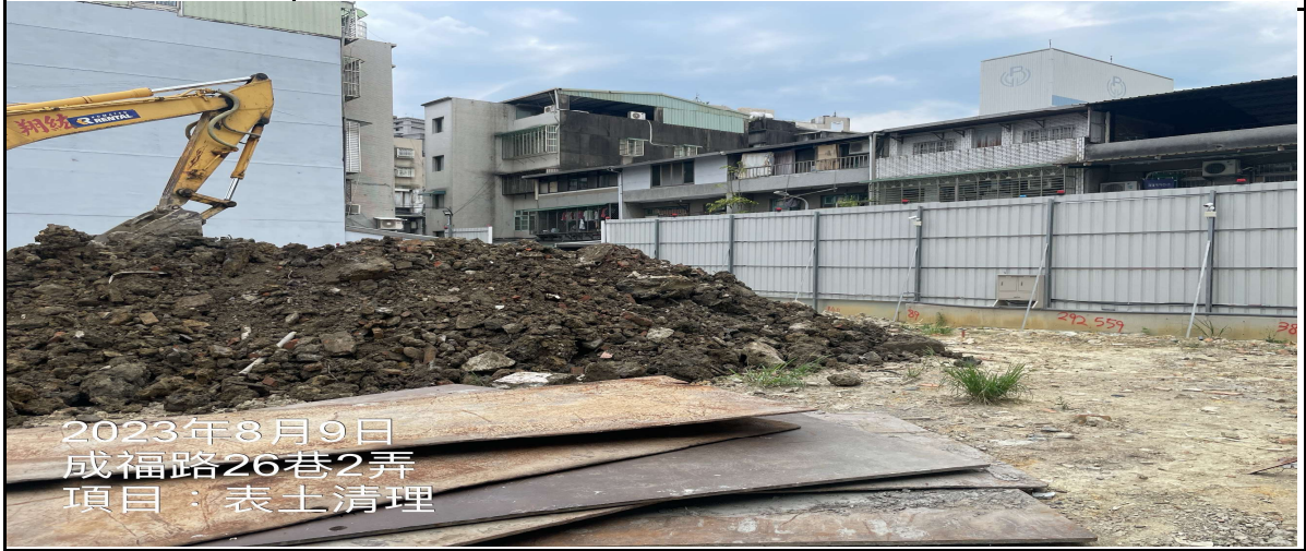
工程名稱: 工區內表土清理
