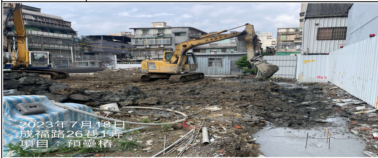
工程名稱: 鄰房側預壘樁施
