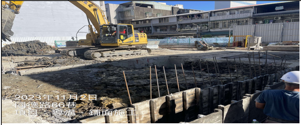
工程名稱: 連續壁-導溝及鋪面
