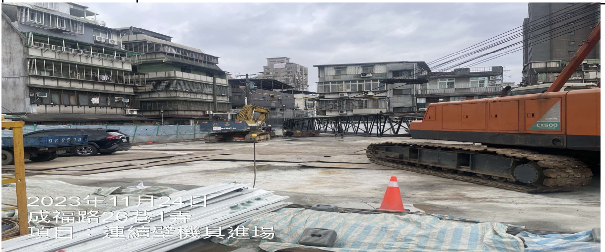
工程名稱: 連續壁機具進場
