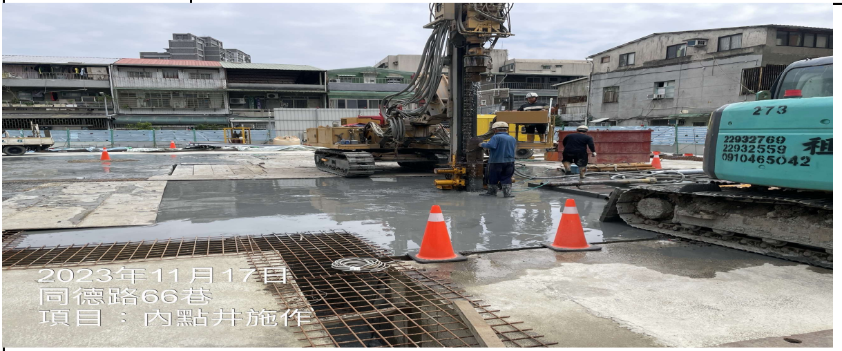
工程名稱: 工區內點井施工
