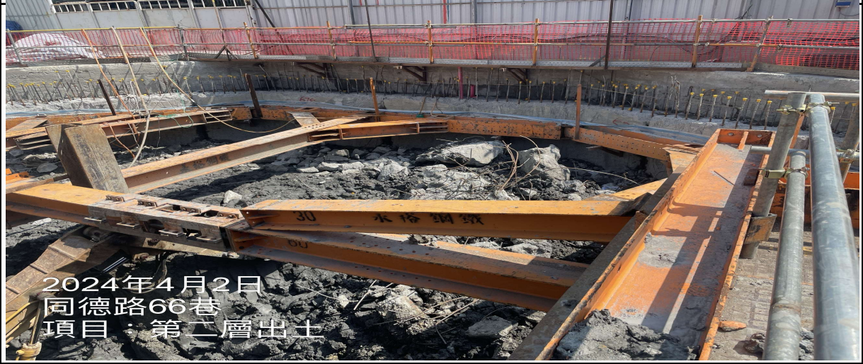
工程名稱: 第二層出土施作
