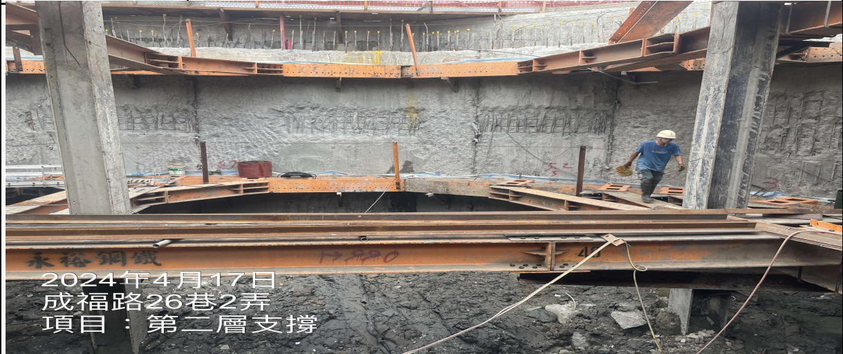
工程名稱: 第二層支撐施作
